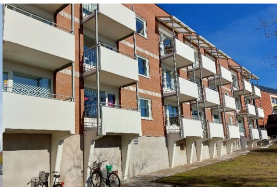
Ombyggnation av bostadsbyggnad på kv, Lejonet
