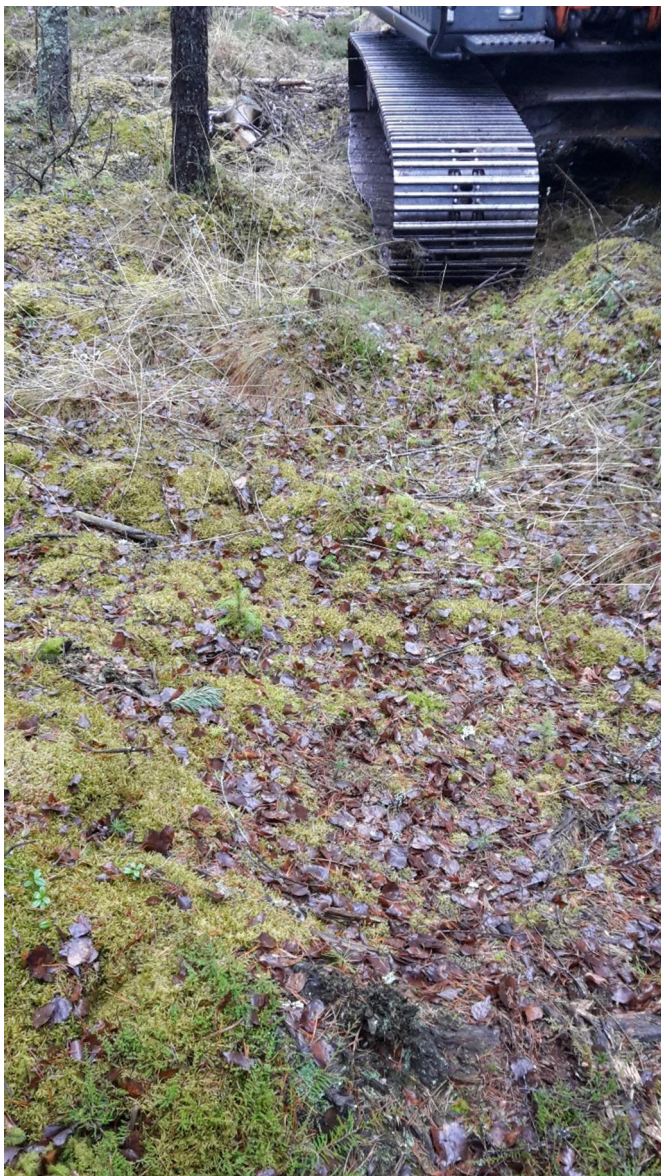
Bild 1. Omgivningsbild runt provgrop Pg 10
